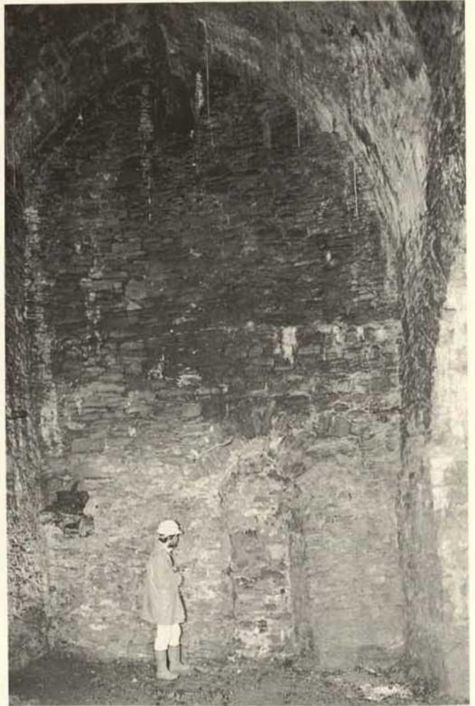
Abb. 2. Goslar, ehem. Erzbergwerk Rammelsberg. Das Feuergezäher Gewölbe, ein in Bruchstein gemauerter und mit spitzbogigem Gewölbe versehener Grubenraum aus der Mitte des 13. Jh. ▽
